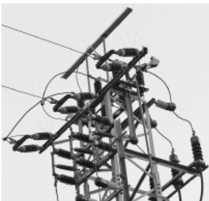
Abb. 4: Mast beim Gemüsegroßmarkt Zeiskam. Hier ist als Schutzmaßnahme ein ELSIC-Sitzbrett montiert, die von Störchen gern als Schlafplatz angenommen werden. Dieses hier ist zu kurz, kürzer als die Traverse. DERA8861, Nahrungsgast aus Baden-Württemberg, fand hier den Tod. Offensichtlich hat er sich an der falschen Stelle niedergelassen oder mit Artgenossen um den Platz gestritten.
